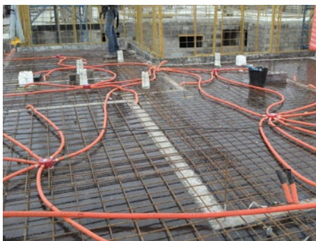
Alvenaria estrutural / vedação
