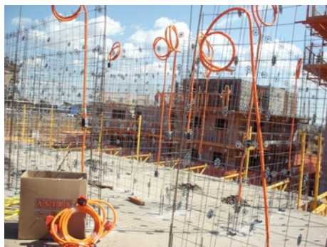
Parede de concreto
